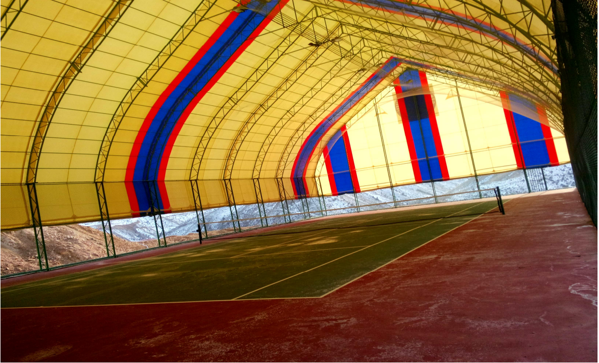
Kapalı, Tenis Sahası,
