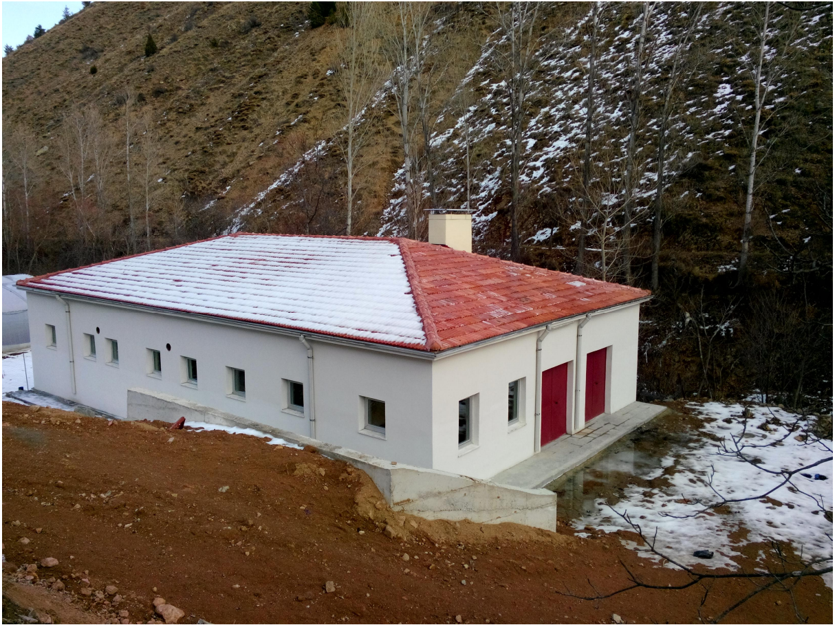
B,ld,rc,n Üretim Tesisi
