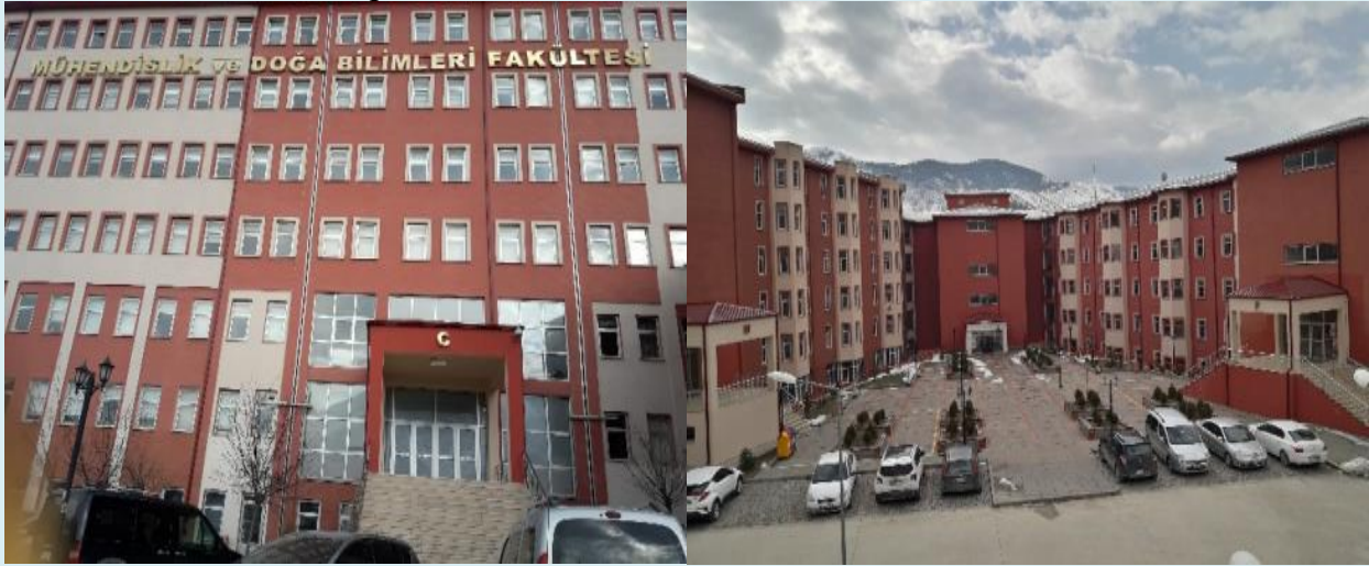
Şekil 1. Fakültemiz Hizmet Binasına Ait Bir Görünüm
