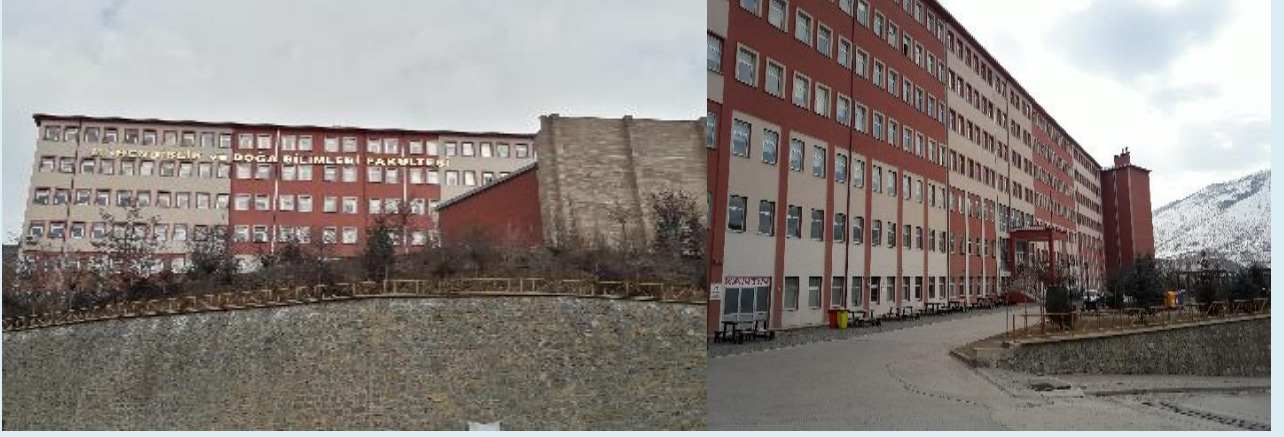
Şekil 2. Fakültemiz Hizmet Binasına Ait Bir Görünüm
